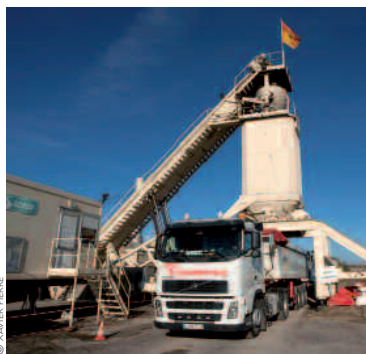
▲ La centrale d'enrobage, installée sur le chantier, assure les livraisons sur site, avec l'avantage de ne pas encombrer les routes ouvertes à la circulation.
